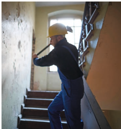
Wer Unterhaltsarbeiten von den Steuern abziehen will, sollte sich sputen: Die Auftragsbücher der Handwerksbetriebe sind bereits gut gefüllt.
