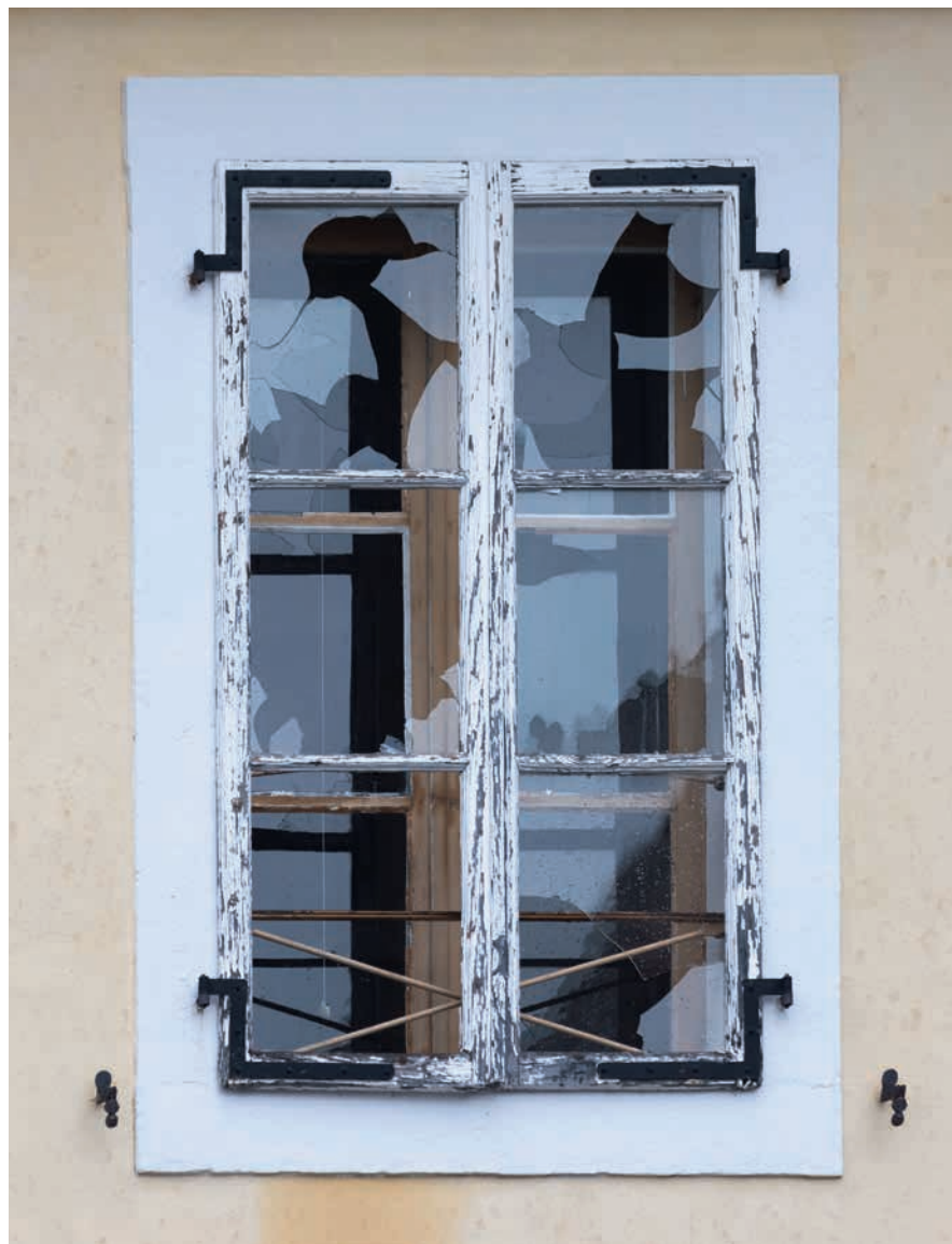
Rund ein Drittel der Gebäudeschäden durch Naturereignisse sind auf Hagel zurückzuführen.
